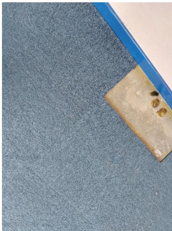
N 2ème Etage / Vol 75 / Colle + ragréage [ Prélèvement n°24]
