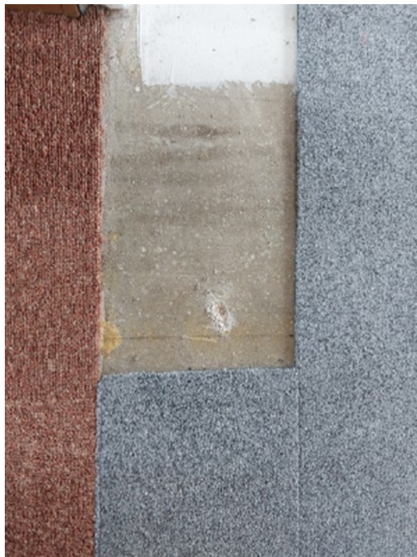
N 2ème Etage / Vol 62 / Colle + ragréage [ Prélèvement n°12]
