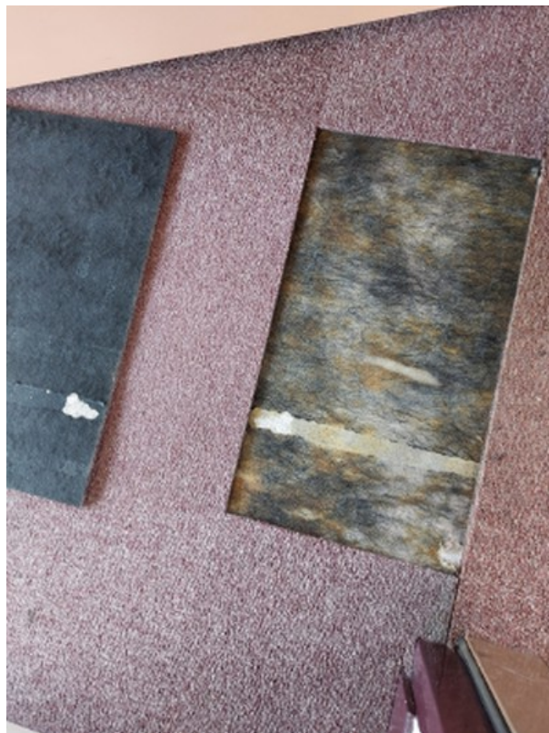
N 2ème Etage / Vol 74 / Colle + ragréage [ Prélèvement n°26]
