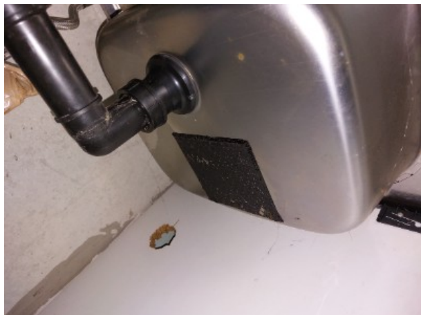
N Sous-sol / Vol 12 / Plaque souple antivibratile [ Prélèvement n°69]
