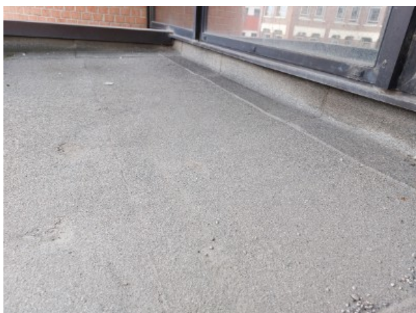
N Extérieur / Toiture / Etanchéité bitumineuse [ Prélèvement n°86]
