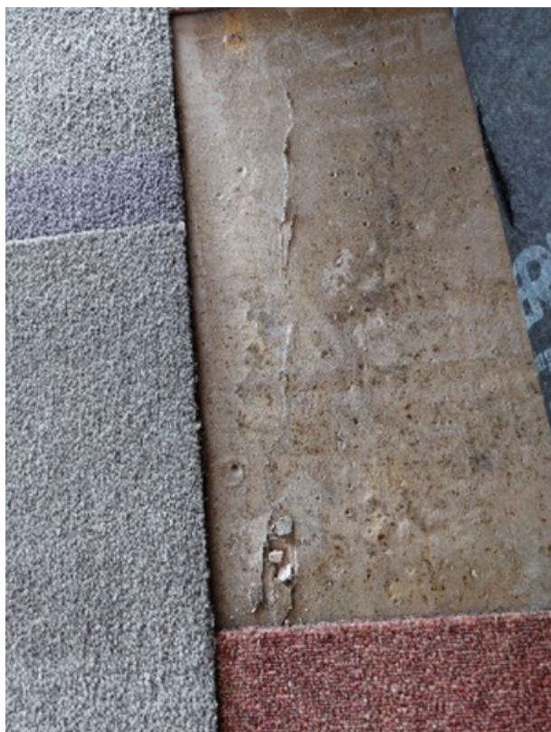
N 2ème Etage / Vol 61 / Colle + ragréage [ Prélèvement n°9]
